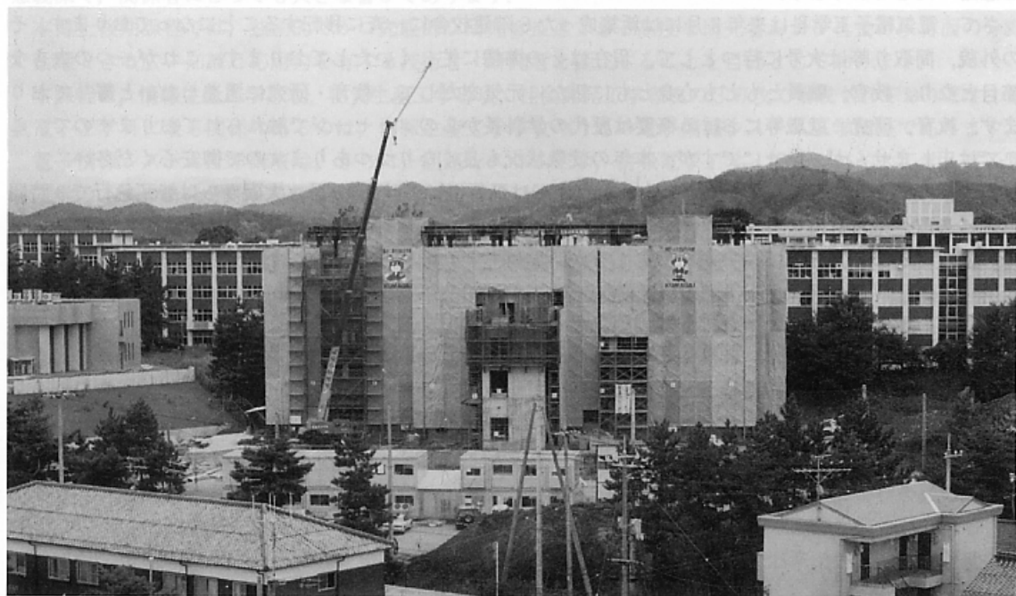
新築校舎の建築工事風景。平成9年4月から電気電子工学科が移転予定。(平成8年10月撮影)
